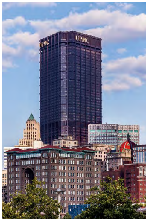
Ryc. 1.7. 40 tys. ton metrycznych stali tworzy 256-metrową US-Steel Tower w Pittsburghu, w Pensylwanii – budynek byłej siedziby głównej US Steel, a obecnie biura UPMC (University of Pittsburgh Medical Center). (Zdjęcie Roberta Strovera, udostępnione za pozwoleniem autora. www.robertstrovers.com )
